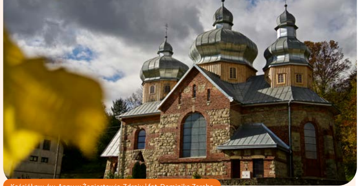
Kościół pw. św. Anny w Żegiestowie-Zdroju | fot. Dominika Zaręba
