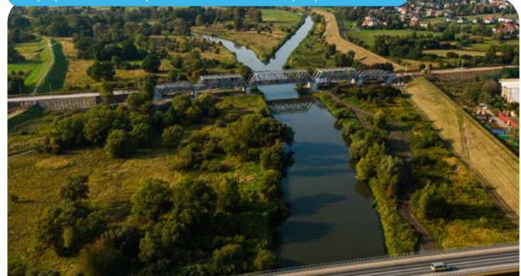
Kolejowy most kratownicowy na Wiśle i linia Trzebinia – Oświęcim | fot. Kamil Sorocki
