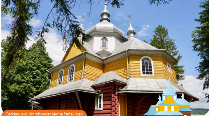
Cerkiew pw. Wniebowstąpienia Pańskiego w Gładyszowie | fot. Dominika Zaręba
