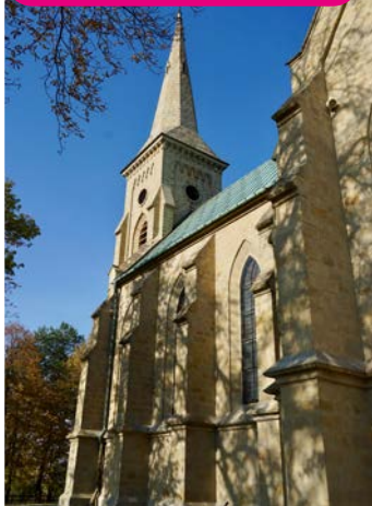
Kościół pw. Trójcy Przenajświętszej w Okocimiu | fot. Dominika Zaręba
