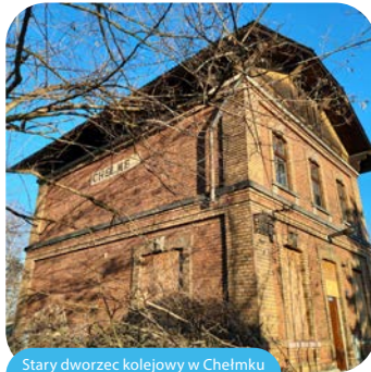
Stary dworzec kolejowy w Chelmku | fot. Waldemar Rudyk
