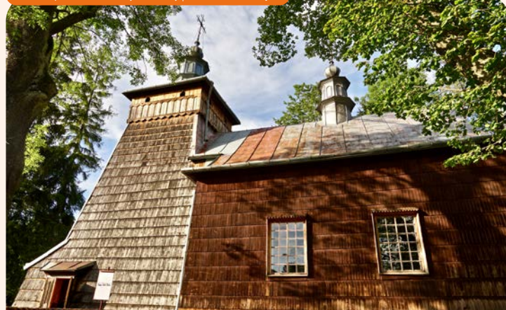
Cerkiew pw. św. Paraskewy w Nowicy | fot. Dominika Zaręba
